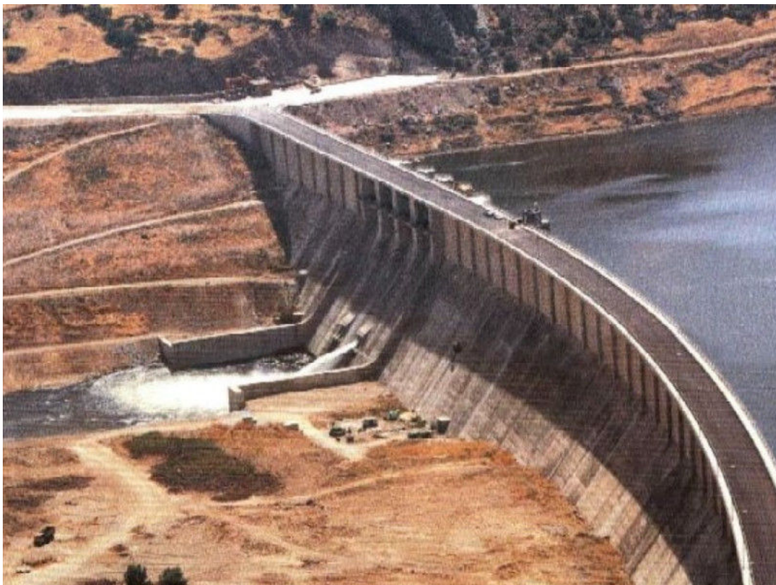
Presa de Alange
